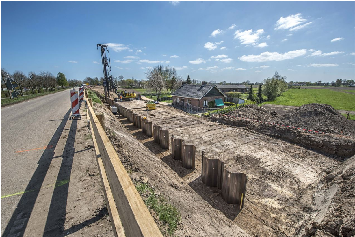
Figuur 7.9 Impressie werkzaamheden en materieel
