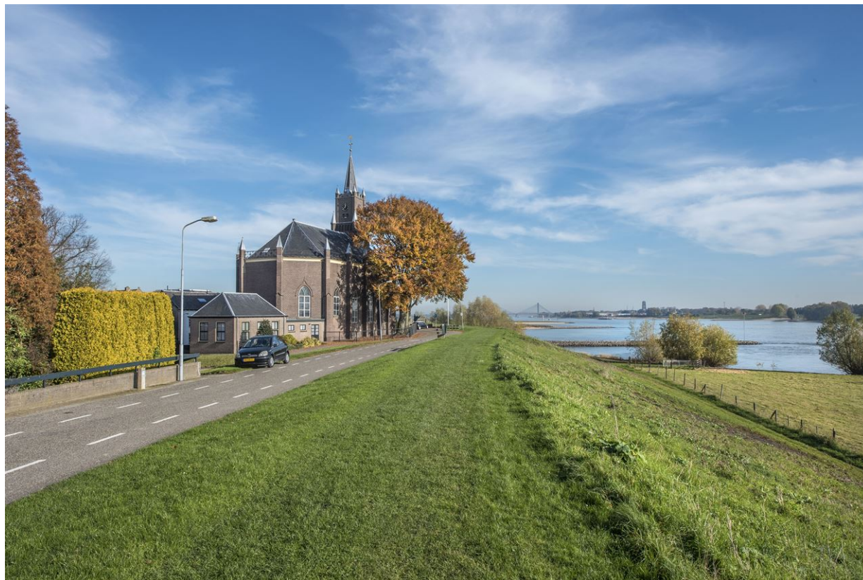
Figuur 3.3 Foto van de dijk
