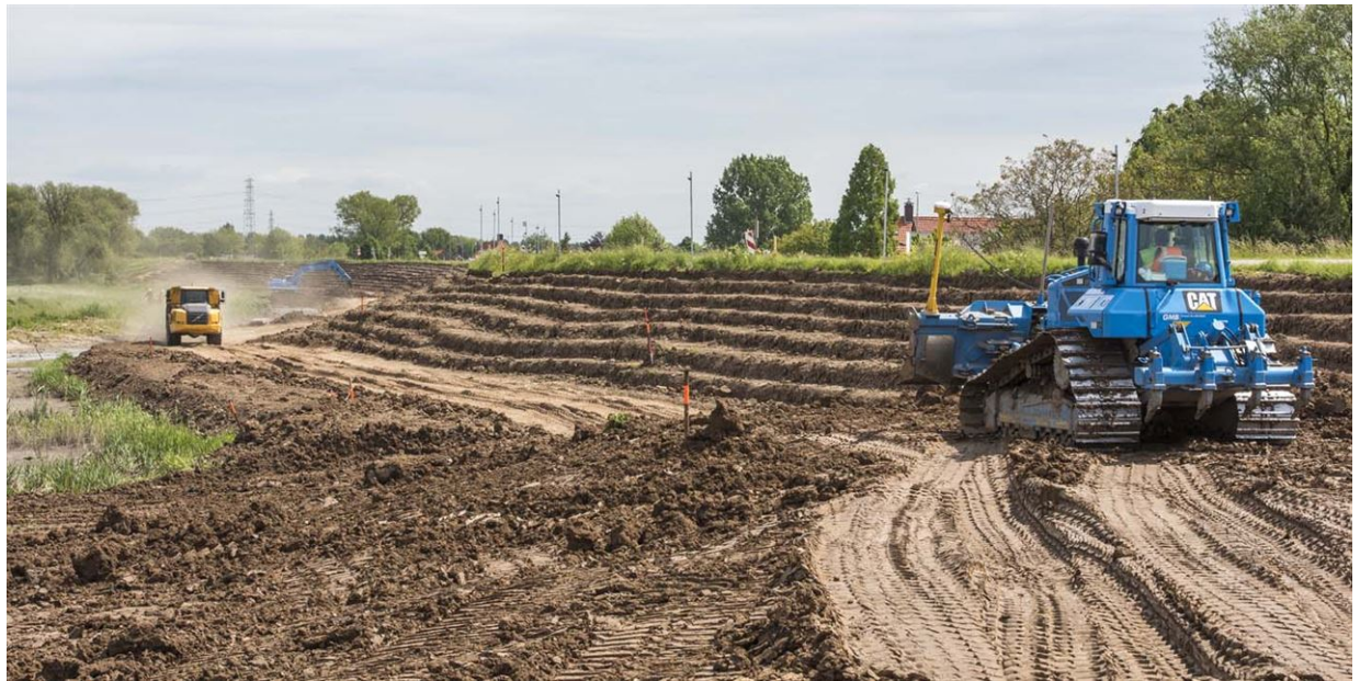
Figuur 7.1 Werkzaamheden aan de dijk bij dijkversterking Hagestein-Opheusden
