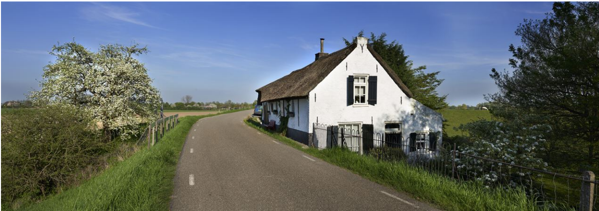
Figuur 1.1 Foto van de dijk
