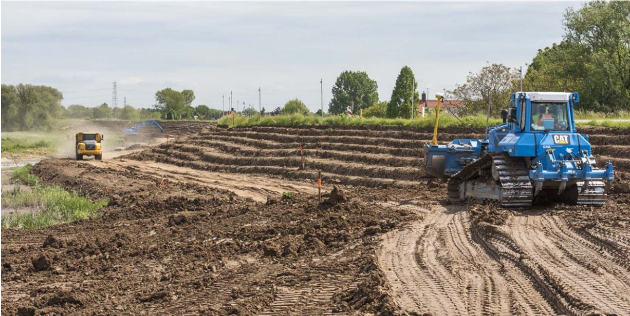
Figuur 4.16 Werkzaamheden aan de dijk bij dijkversterking Hagestein-Opheusden
