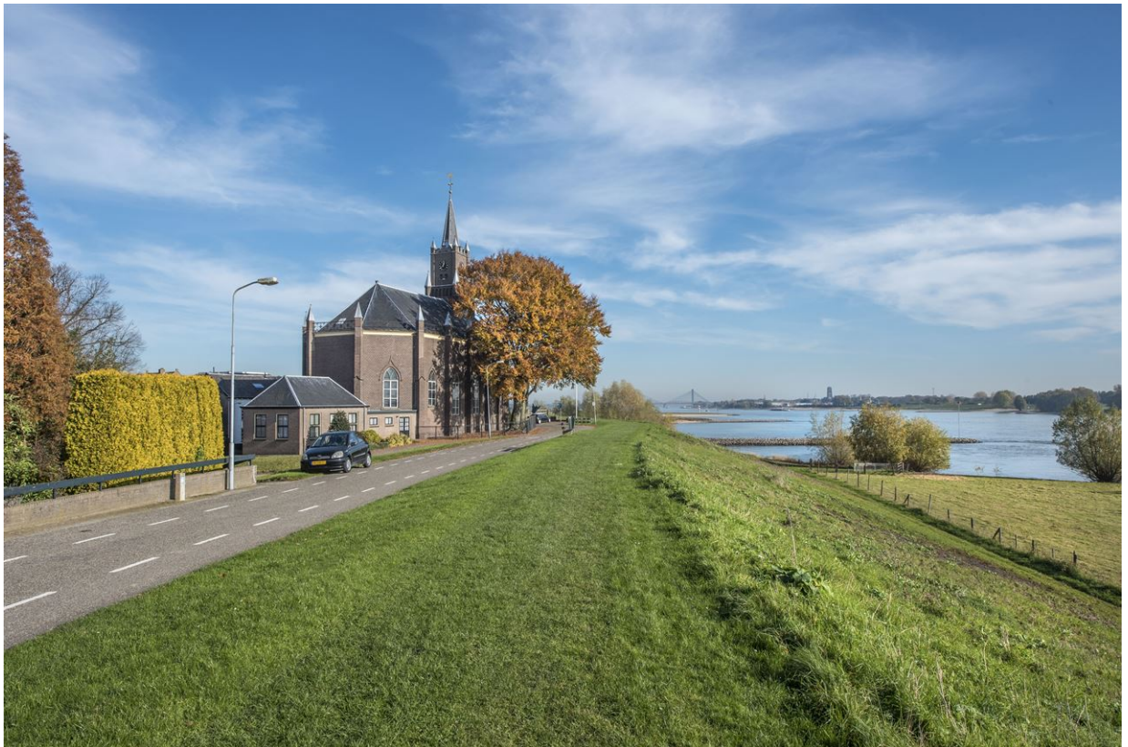
Figuur 3.3 Foto van de dijk
