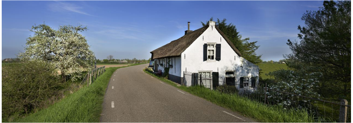
Figuur 2.10 Foto van de dijk
