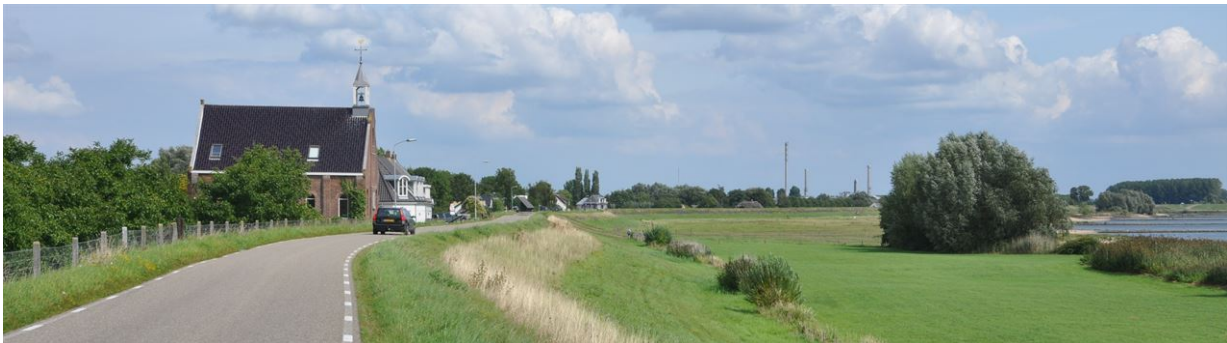
Figuur 1.1 Foto van de dijk
