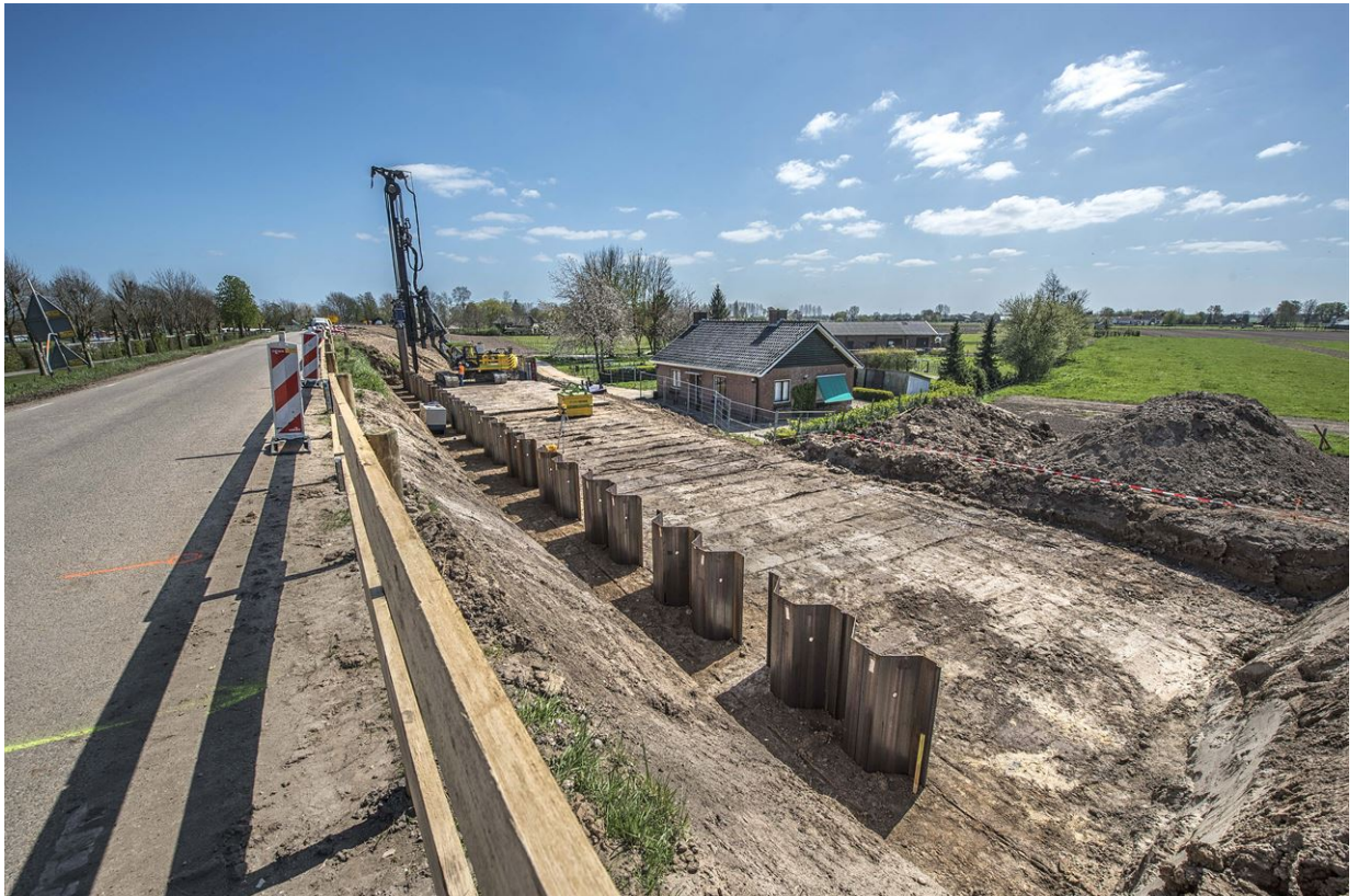
Figuur 7.9 Impressie werkzaamheden en materieel
