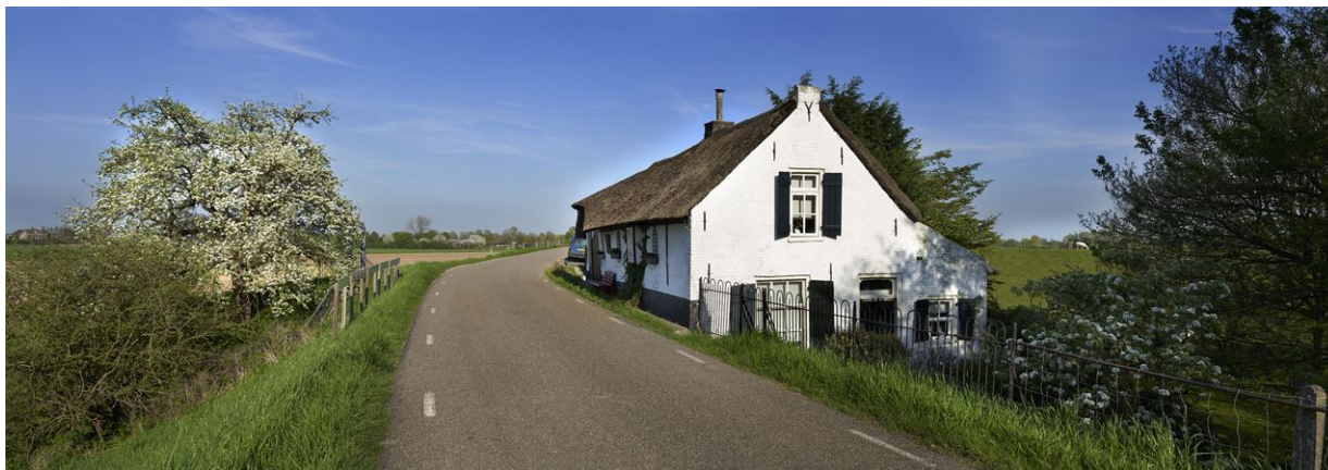
Figuur 2.10 Foto van de dijk
