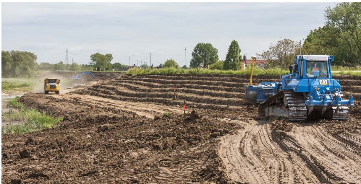
Figuur 7.1 Werkzaamheden aan de dijk bij dijkversterking Hagestein-Opheusden
