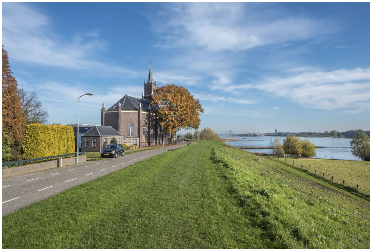
Figuur 3.3 Foto van de dijk
