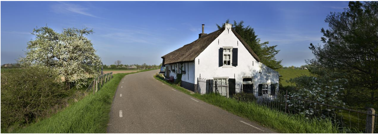
Figuur 1.1 Foto van de dijk
